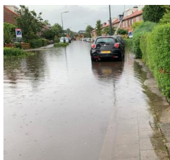
Figuur 2: Nieuwsberichten op Wijdmeren.nieuws.nl van 12 juli 2019 (boven). Locaties kwetsbaar voor wateroverlast in Nieuw Loosdrecht (links). De kaart toont de waterdiepte op straat nadat er 120 millimeter in 1 uur is gevallen. Ook ziet u welke wegen wel en niet begaanbaar zijn.
