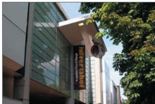
Winkelcentrum Hilvertshof in Hilversum centrum
