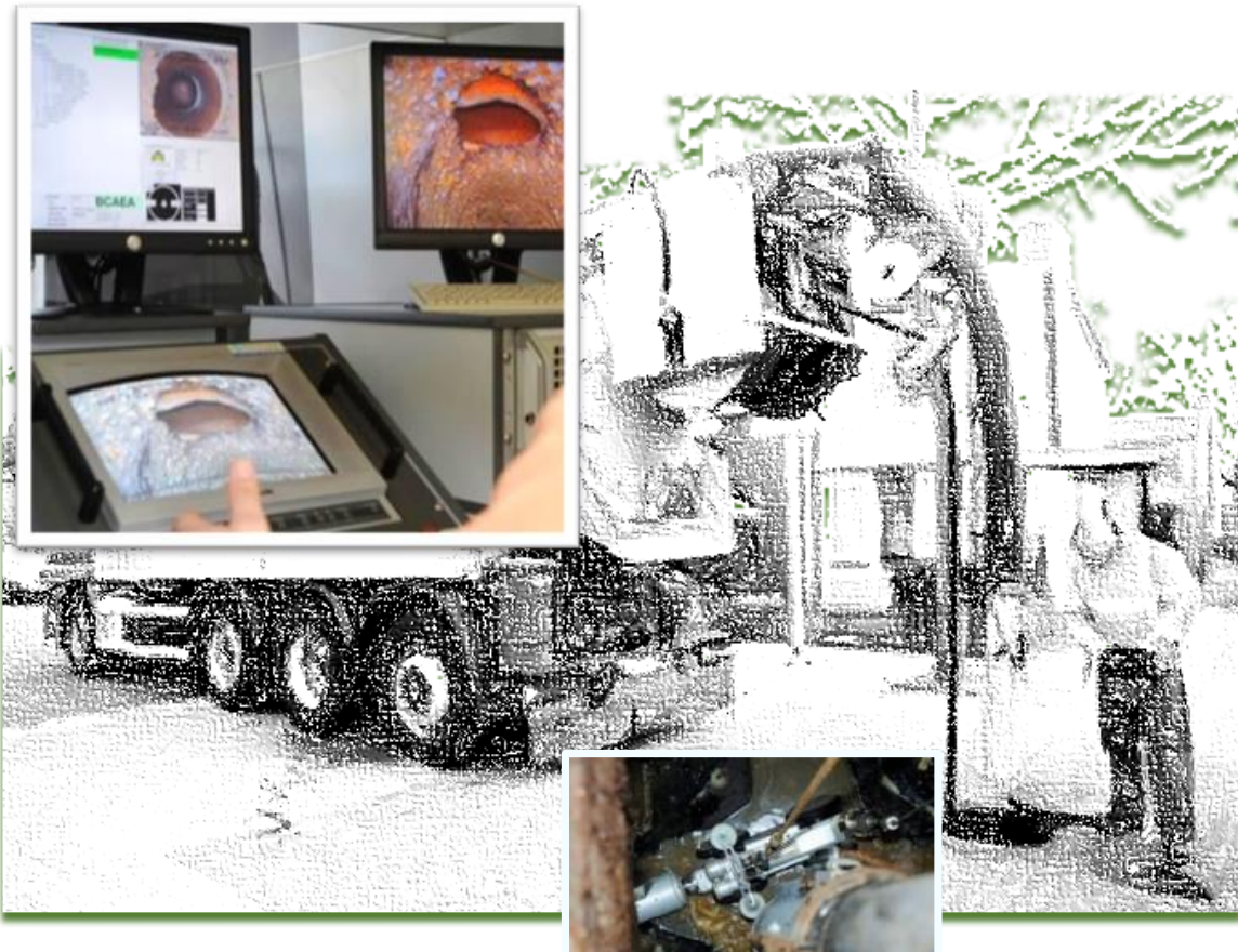
figuur 9: Reiniging en inspectie van het rioolstelsel (leidingen en gemalen)
