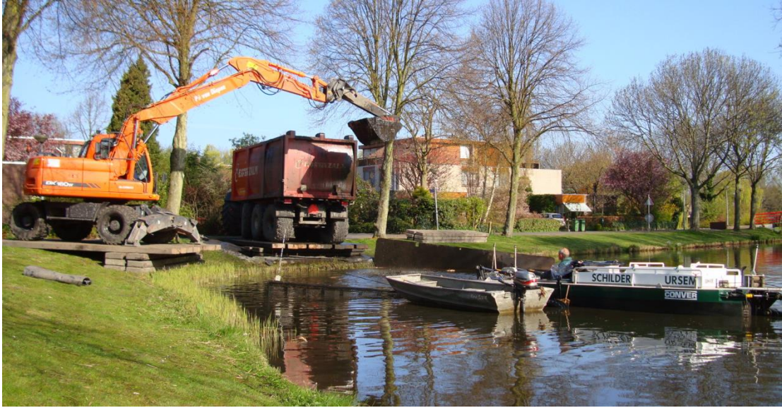
De uitvoering van baggerwerk in stedelijk gebied
