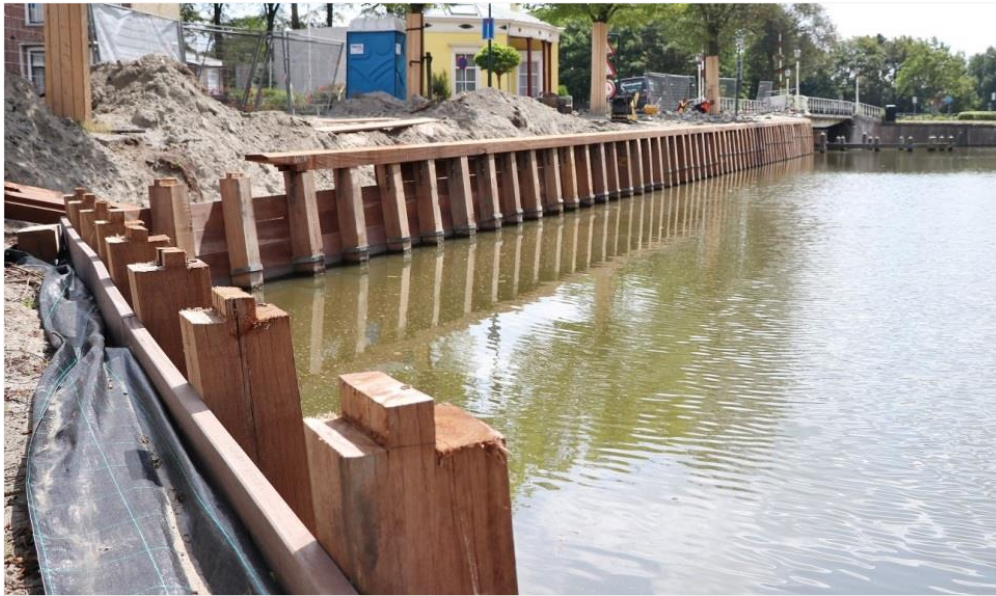
Aanbrengen van oeverbescherming
