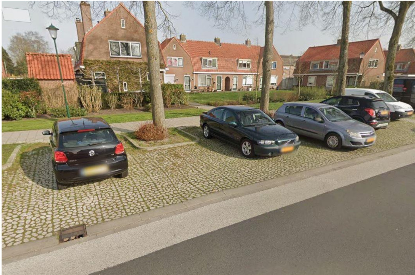
Haaksparkeervakken met grasbetontegels conform fase 1
