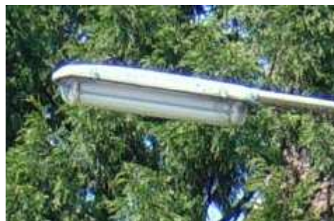
Figuur 10 Verouderd armatuur met TLS20
